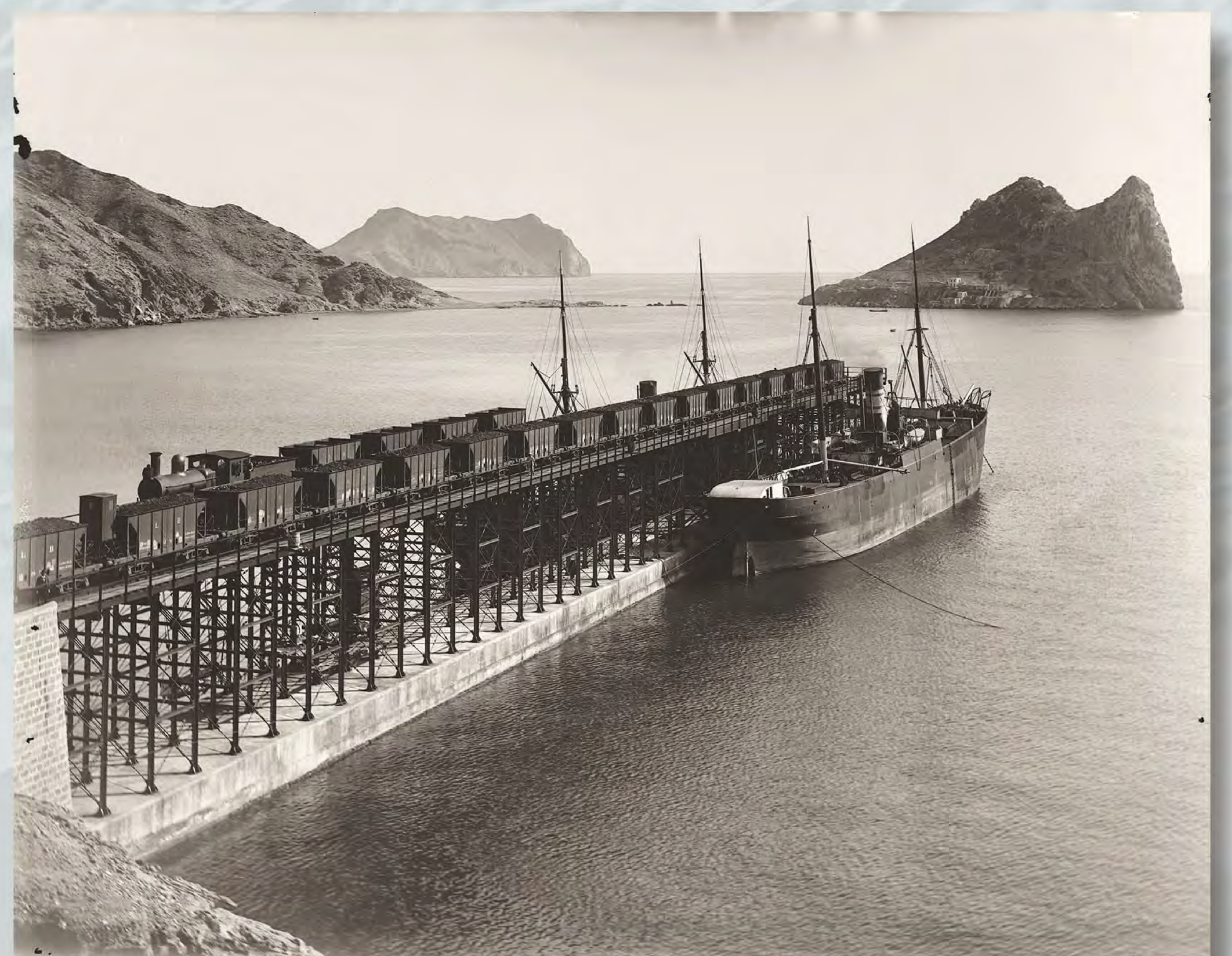
Fotografía de Gustavo Gillman. Vista panorámica del embarcadero de mineral de El Hornillo. Fuente: Archivo General de la Región de Murcia. Ref.: FOT_NEG-127_002.
