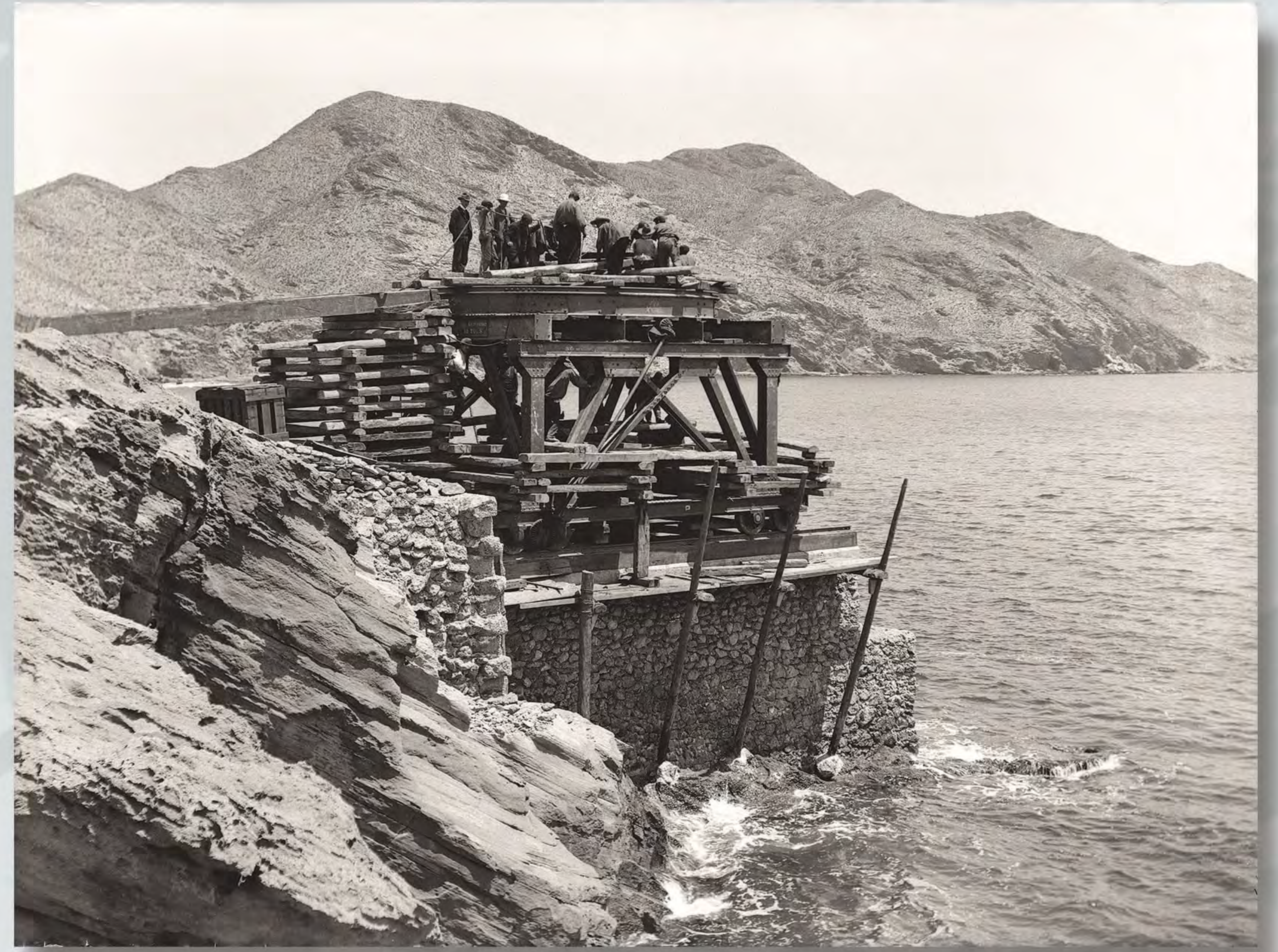
Fotografía de Gustavo Gillman. Erección de la grúa Titán en la playa de El Hornillo de Águilas. Fuente: Archivo General de la Región de Murcia. Ref.: FOT_NEG-108_024.
